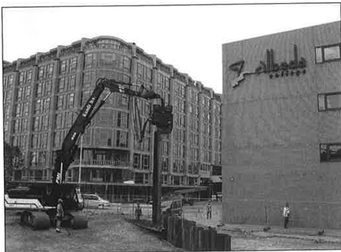
FIGUUR 1: GELUID EN TRILLINGEN INTRILLEN DAMWAND CONRADSTRAAT ROTTERDAM
