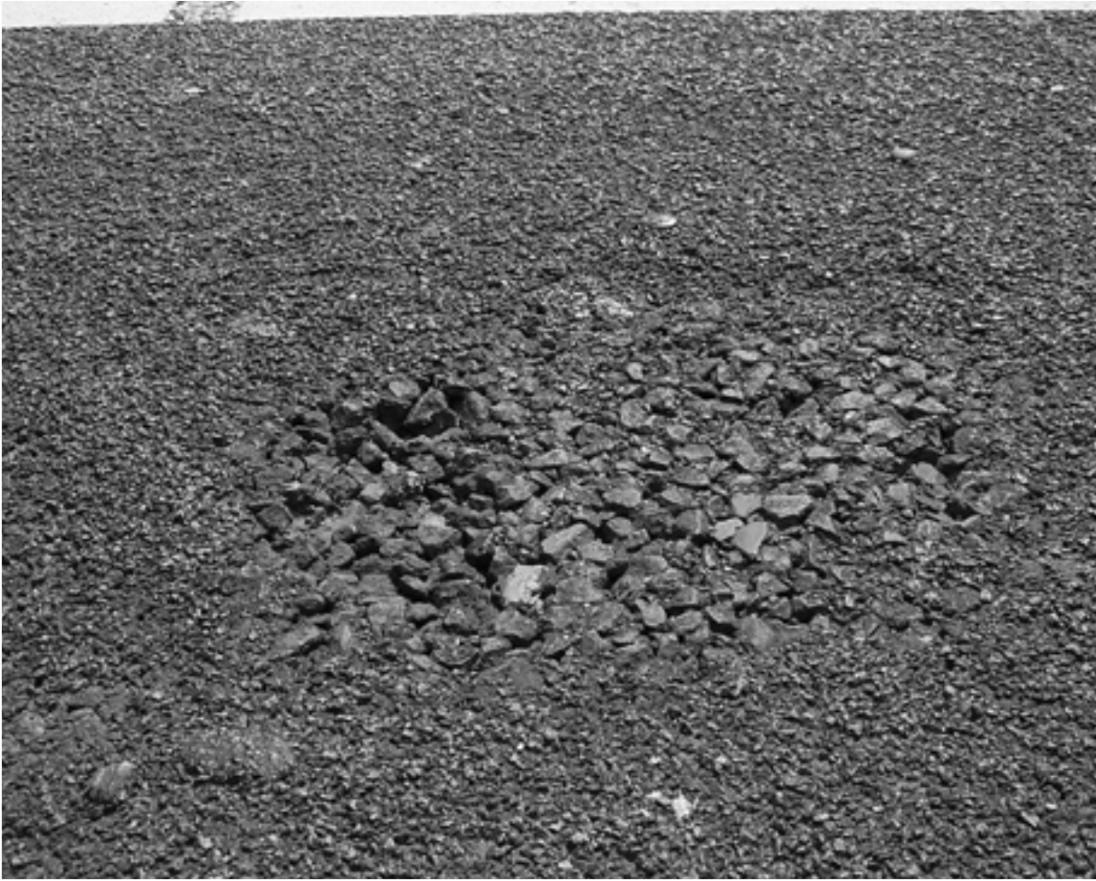
VOORBEELD VAN EEN GERAFELDE TOPLAAG
