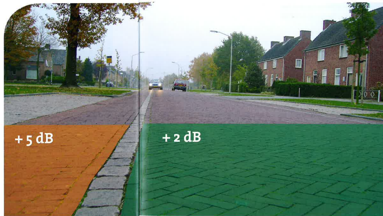
Voorbeeld van een elementenverharding met een verschillende toeslag voor de geluidemissie voor de rijbaan in keperverband en de fietssuggestiestrook in halfsteensverband.
