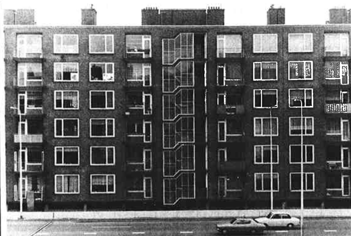
Figuur 8: Gevelaanzicht woongebouw direct langs de rijksweg, na sanering.
