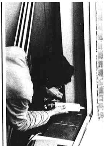
Figuur 12: Zorgvuldige afdichting kozijnaan-sluiting tegen bouwmuur met behulp van elastisch blijvende kit.
