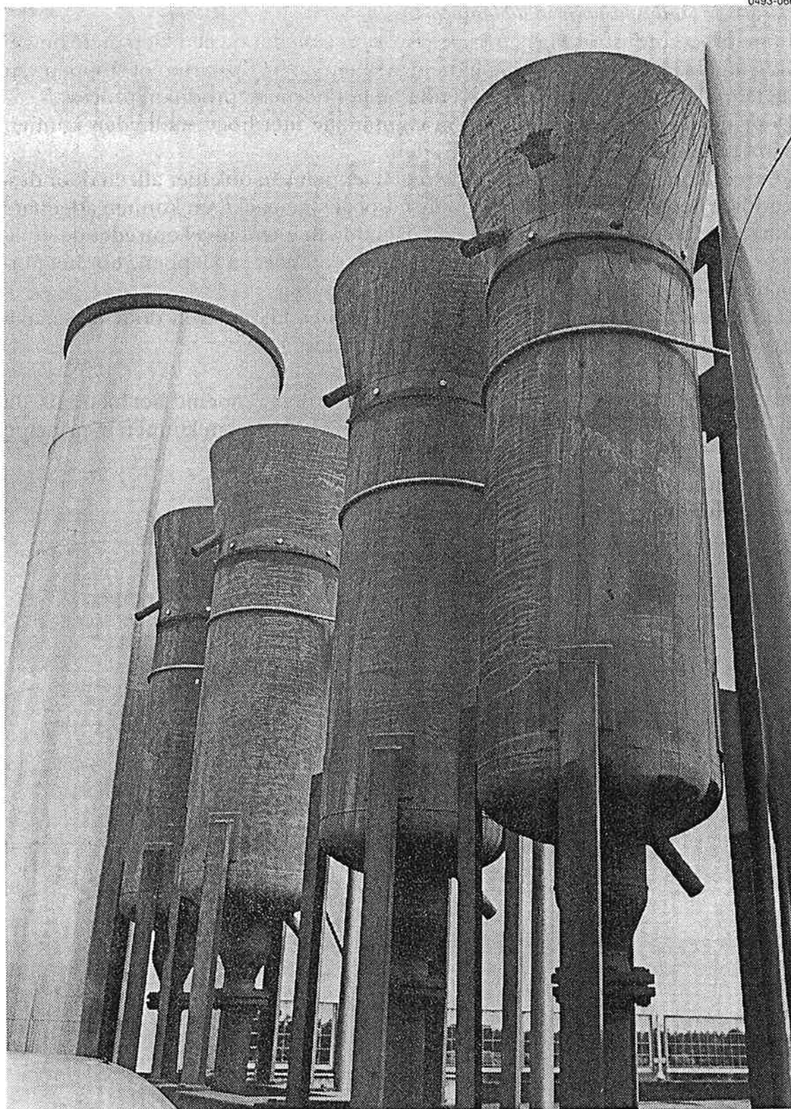
Figuur 16. Stoomafblaasdemper (foto Gerber Nederland).
