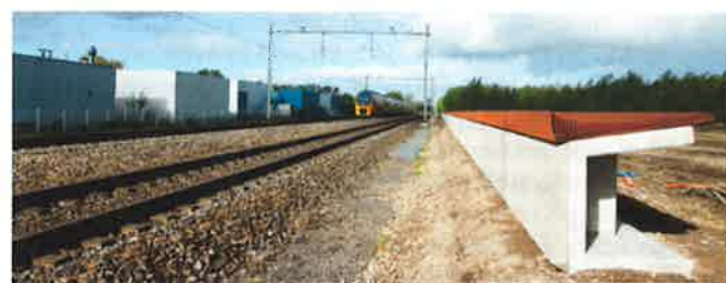
FIGUUR 2: INNOVATIES ROND GELUIDSCHERMEN (LINKS: T-TOP, A2 BIJ BEST; RECHTS: DIFFRACTOR OP LAAG SCHERM BIJ SUSTEREN)
