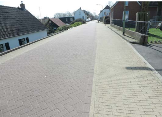
Elementenverhardingen dicht bij de huizen, met een fietssuggestiestrook in het lawaaiige halfsteensverband (Buitendijk Hank).
