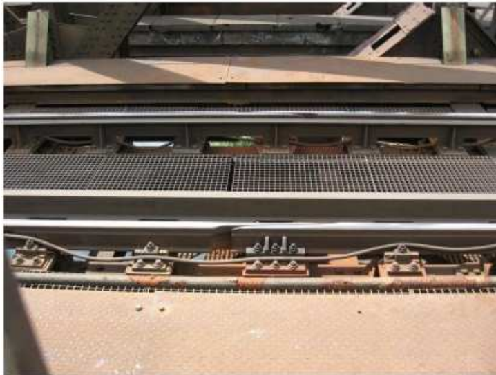
Figuur 2-3 Compensatie las op de brug
