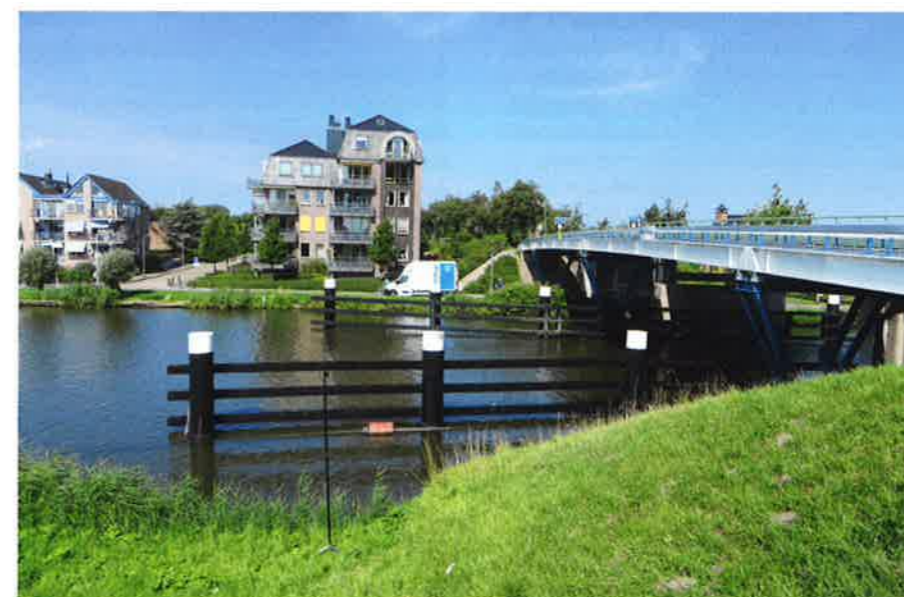
Voorbeeld van een provinciale weg met een stalen brug middenin een waterrijk dorp.
