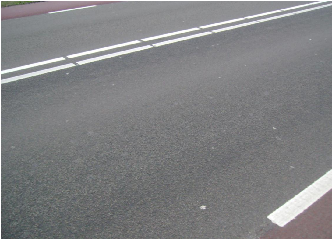
Figuur 4 Rafeling op de oude dunne geluidreducerende deklaag
