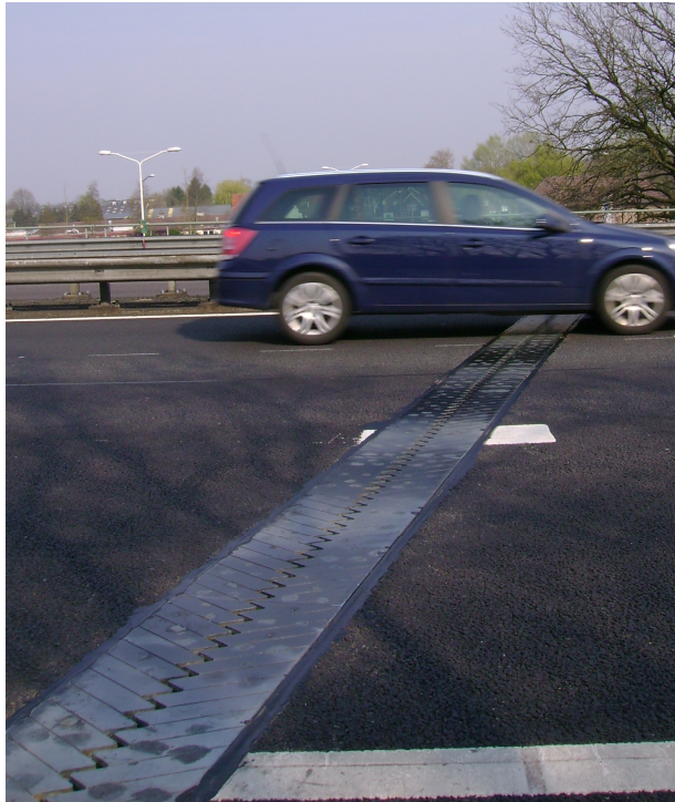
Links een voeg met randprofiel en geluidmaatregel (1s), rechts een lamellenvoeg met geluidmaatregel (7s)
