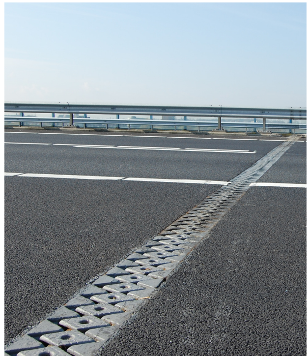
Links een voeg met randprofiel en geluidmaatregel (1s), rechts een lamellenvoeg met geluidmaatregel (7s)
