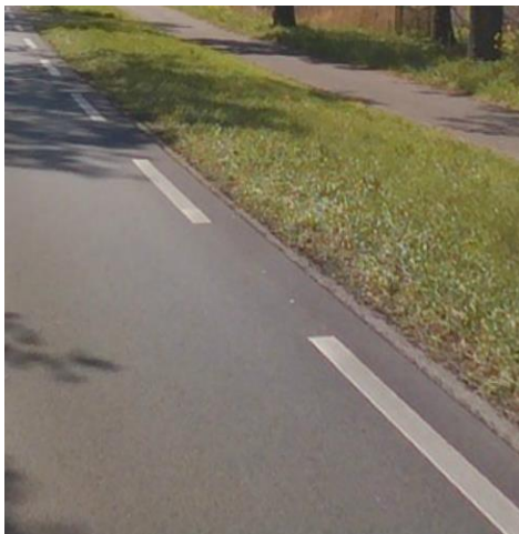
N65 Vught (zaagtandmarkering)
