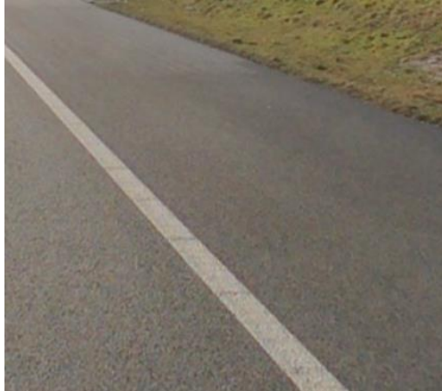
A4 Steenbergen (spetterplast op thermo)
