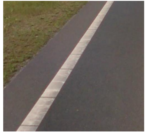
N36 Rheezerveen (geprofileerde kantstrepen)
